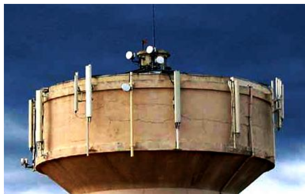
Le château d'eau de Villeneuve-de-la-Raho
