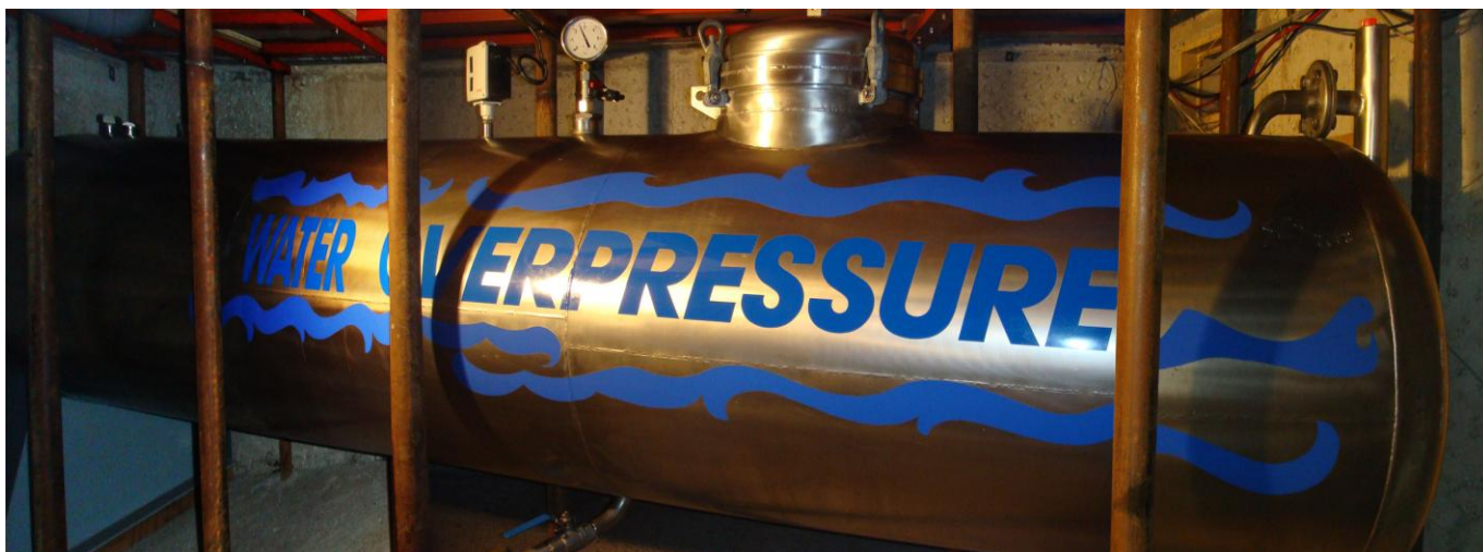
Le grand supprimeur terminal opérationnel en inox 316L de 6 m de long de l'unité de stockage (photo anamorphosée)
